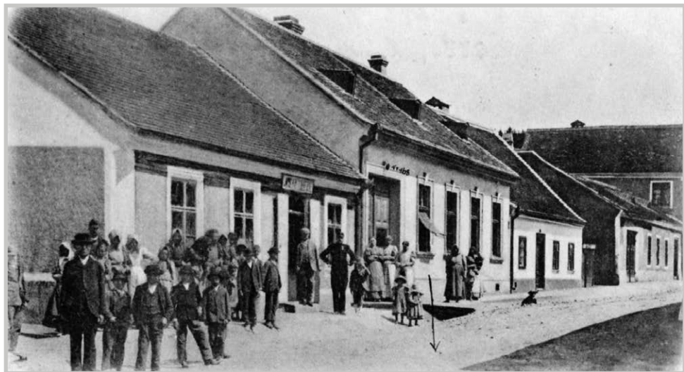
Pohled do Komenského ulice cca r. 1898. Vlevo rohový dům čp. 139, dnes výrazně přestavěný, v němž pamatujeme papírnictví, tehdy obchod Josefa Taufara (1863–1925). Dále dosud stojící dům čp. 168 a již neexistující dům čp. 41. Za ním je vidět objekt Palírny, kterou už také dávno odvál čas. (Archiv autora)
