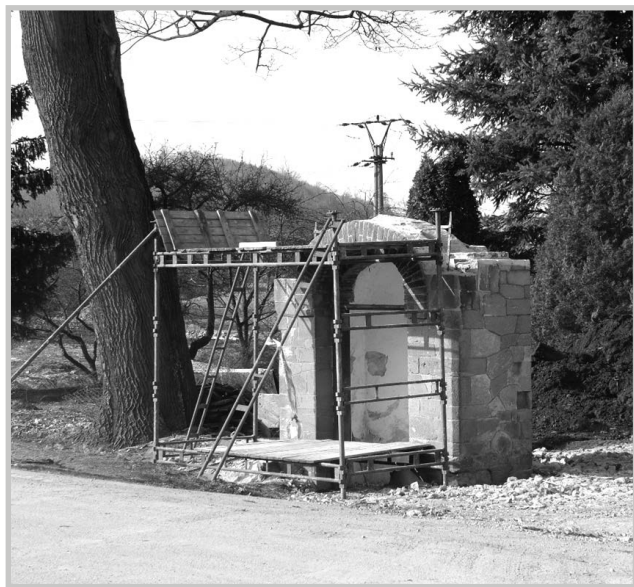
Rozebírání kapličky, 26. 2. 2021. Dům čp. 71 je již zbořen (foto autor)
