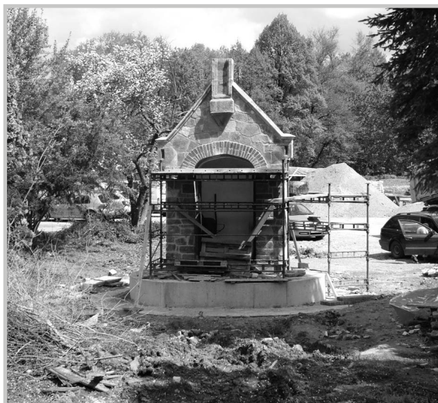
Výstavba kapličky blízke toku Svitavy, 20. 5. 2021 (foto autor)
